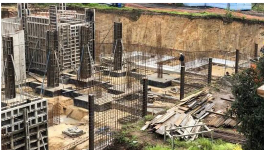
Fundações e cofragens iniciais
