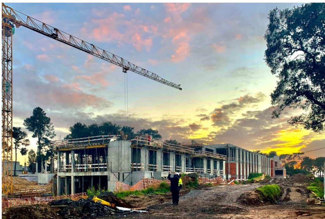
Panorâmica geral da obra
